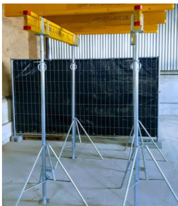
Ukázka podstojkování se stojkami s trojnožkami
