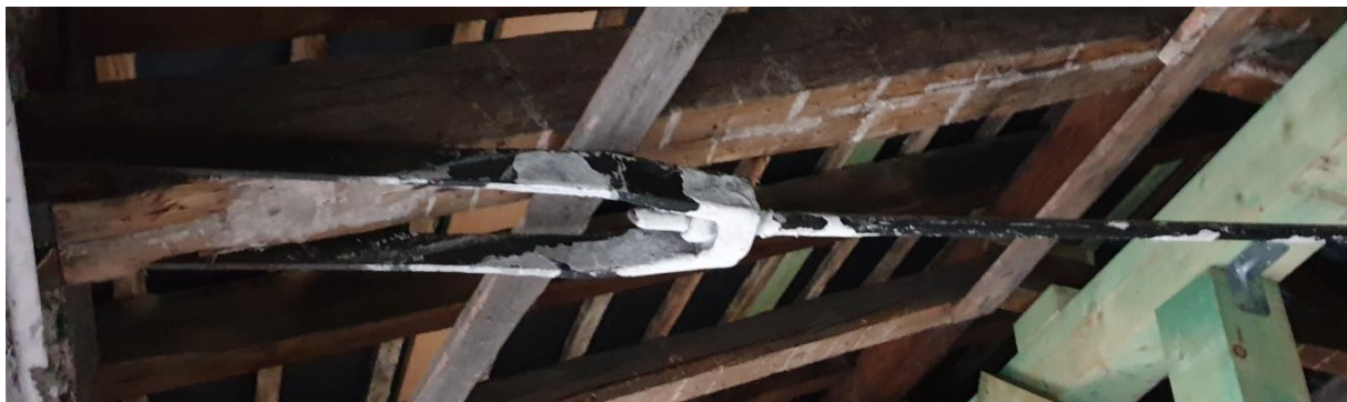
Stávající kotevní vidlička táhla.
